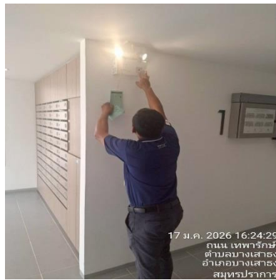
ภาพที่ 2.8 งานบำรุงรักษาระบบดับเพลิง และระบบแจ้งเตือนเหตุเพลิงไหม้
